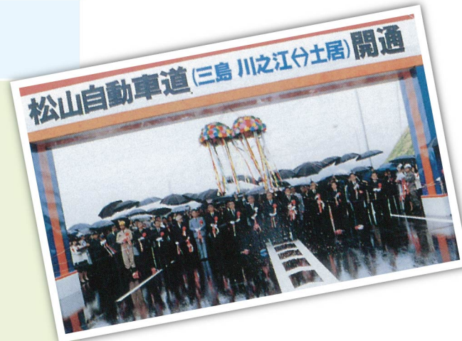
1985年3月 四国初 高速道路が開通 (松山道 三島川之江～土居)
